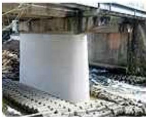
PP（ポリマーセメントモルタル）によるピア耐震補強（工法（右写真）、PSR（ポリマーセメントモルタルによるスラブ補強）工法がそれです。県内での採用も徐々に増えてまいりましたので、近
